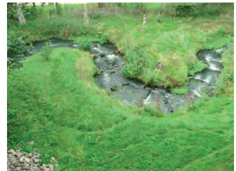
Fischaufstieg an der Zainhammer Mühle
